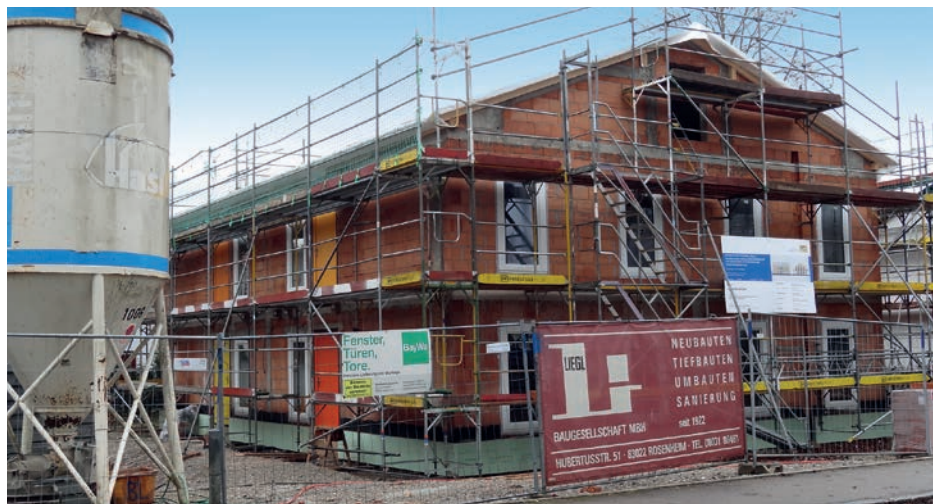
Bau von Sozialwohnungen in der Parkstraße
